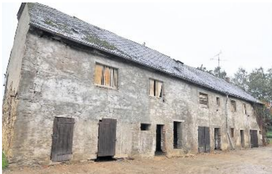
In diesem Haus auf dem Grundstück Bockelwitz Nr. 3 sollen Ausbildungswerkstätten und Wohnungen für Jugendliche entstehen. Die Dachdecker könnten noch im Oktober starten.
